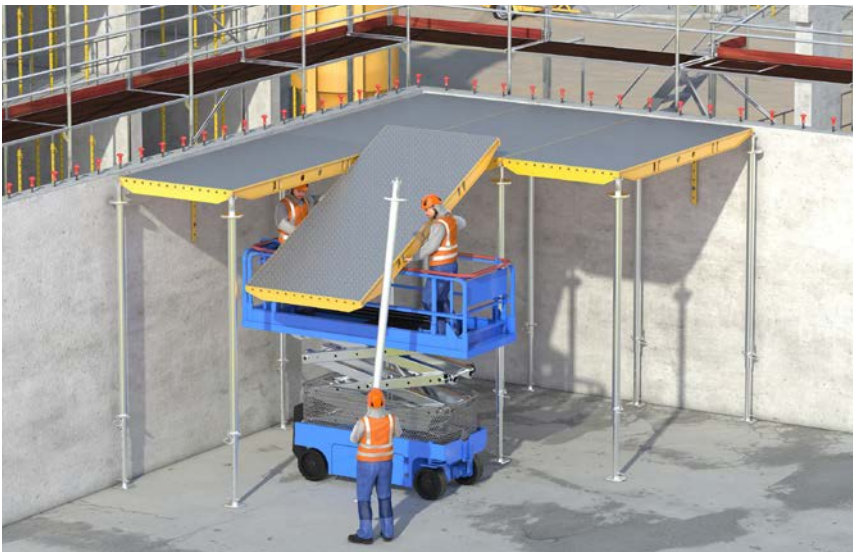
Abb. 6b Aufbau von Deckenschalungssystemen mittels Hubarbeitsbühne
