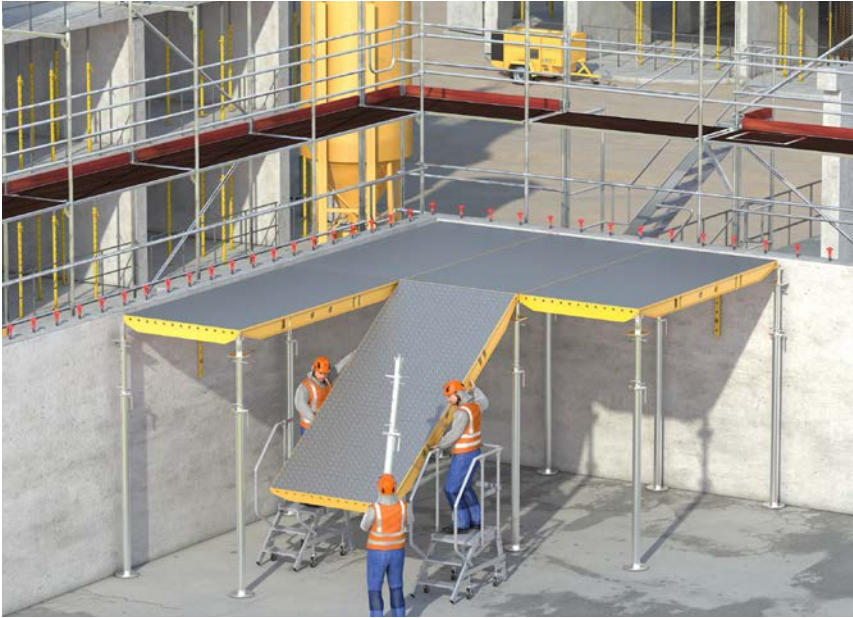
Abb. 6a Aufbau von Deckenschalungssystemen mittels Podesttreppe
