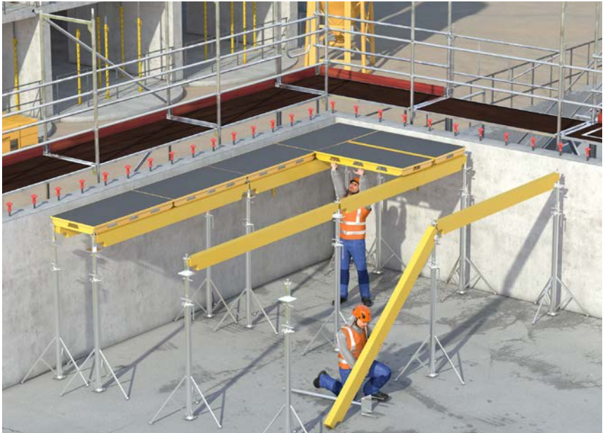
Abb. 5 Aufbau eines Deckenschalungssystems aus einer gesicherten Standposition.
