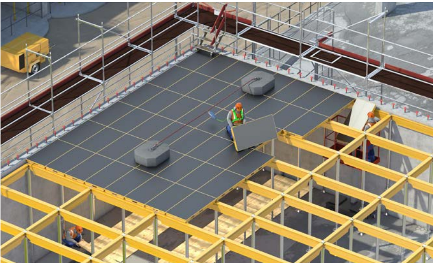
Abb. 7b Aufbau von Deckenschalungssystemen unter Verwendung von PSAG/ Rückhaltesystem bei vorhandenen Störstellen (Bodenvertiefungen)
